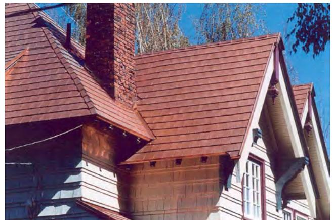
COPPER ROOF SHINGLES BEFORE BEING TREATED WITH MILD ACID TO ACCELERATE OXIDATION
